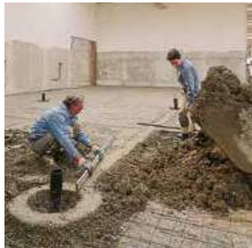
1 – Sottofondo fresco su fresco Substrate wet on wet
